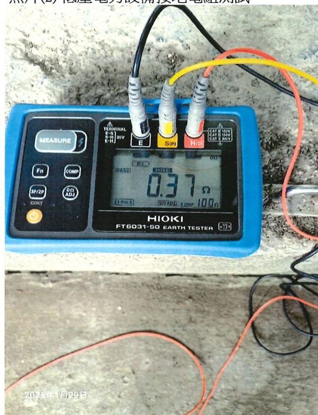
照片(2) 低壓電力設備接地電阻測試
