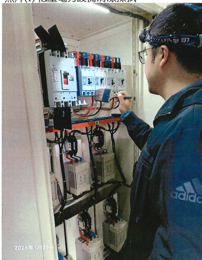
照片(1) 低壓電力設備清潔擦拭
